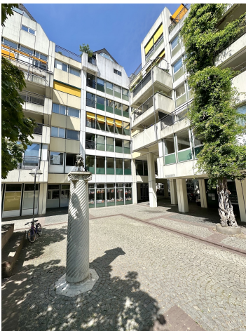
Blick vom Innenhof
