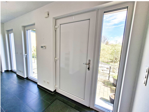
Hausflur mit bodentiefen Fensterelementen
