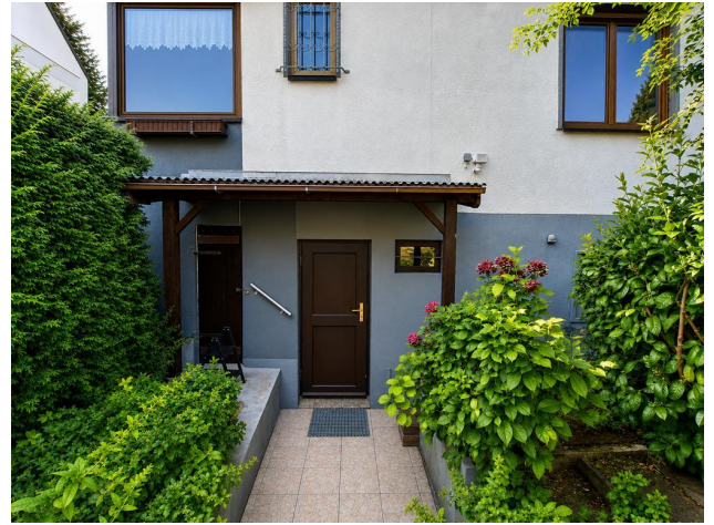
Zugang zum Keller
