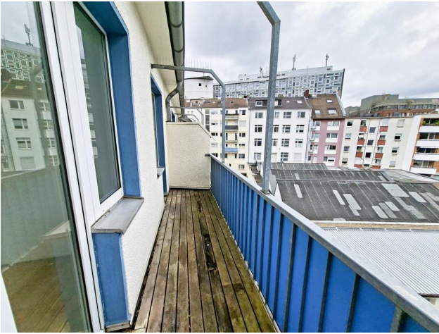
Balkon zur Rückseite (Garagenhof)
