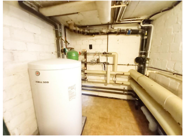
Warmwasseraufbereitungsanlage
