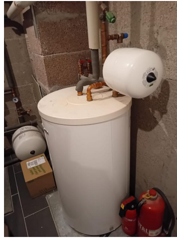
Warmwasserspeicher
