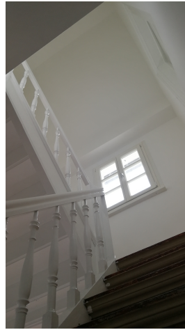
WE OG Treppenhaus
