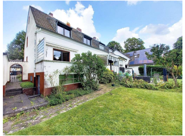
Seitenansicht Garage und Kellervorraum
