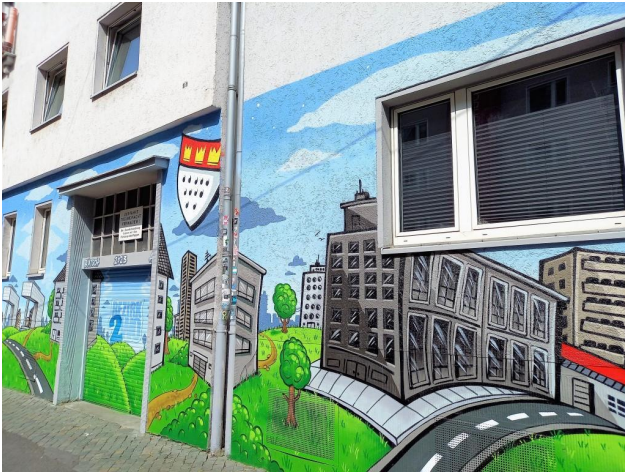
Garageneinfahrt mit Rolltor und Zugang Rückseite zum Hinterhof
