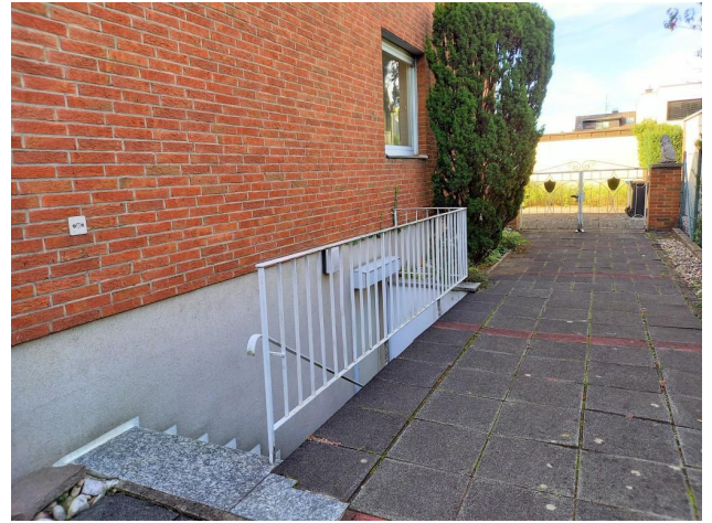
Seiteneingang Souterrain/Keller mit Licht und Handlauf
