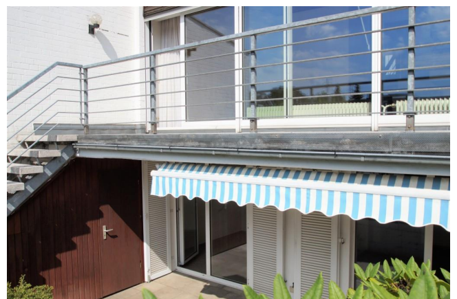
Treppe zur unteren Terrasse und Garten
